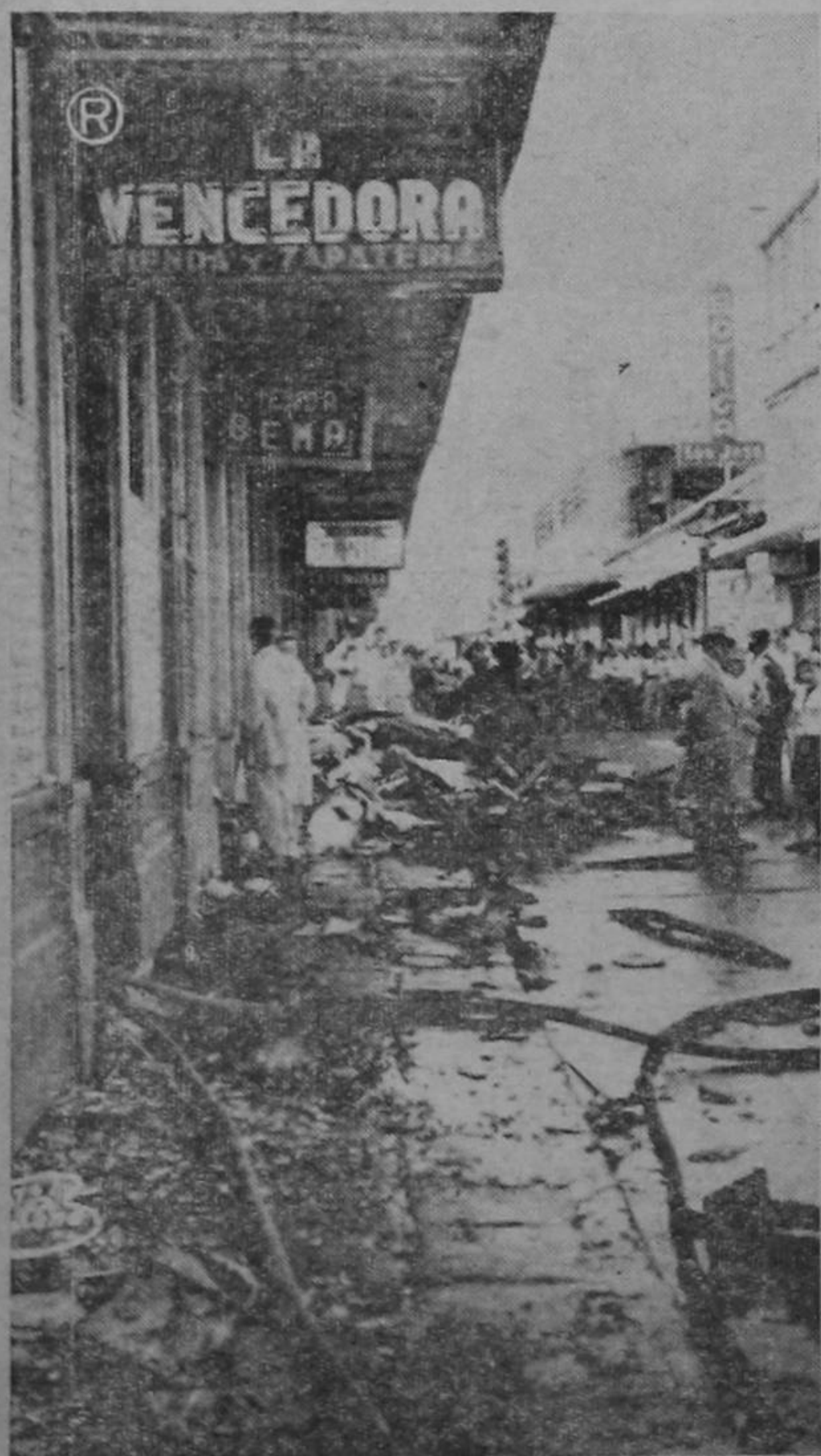
El público se arracima para observar los daños que por valor de tres millones de colones, produjo el incendio de ayer, en uno de los sectores comerciales más importantes de la ciudad capital.
